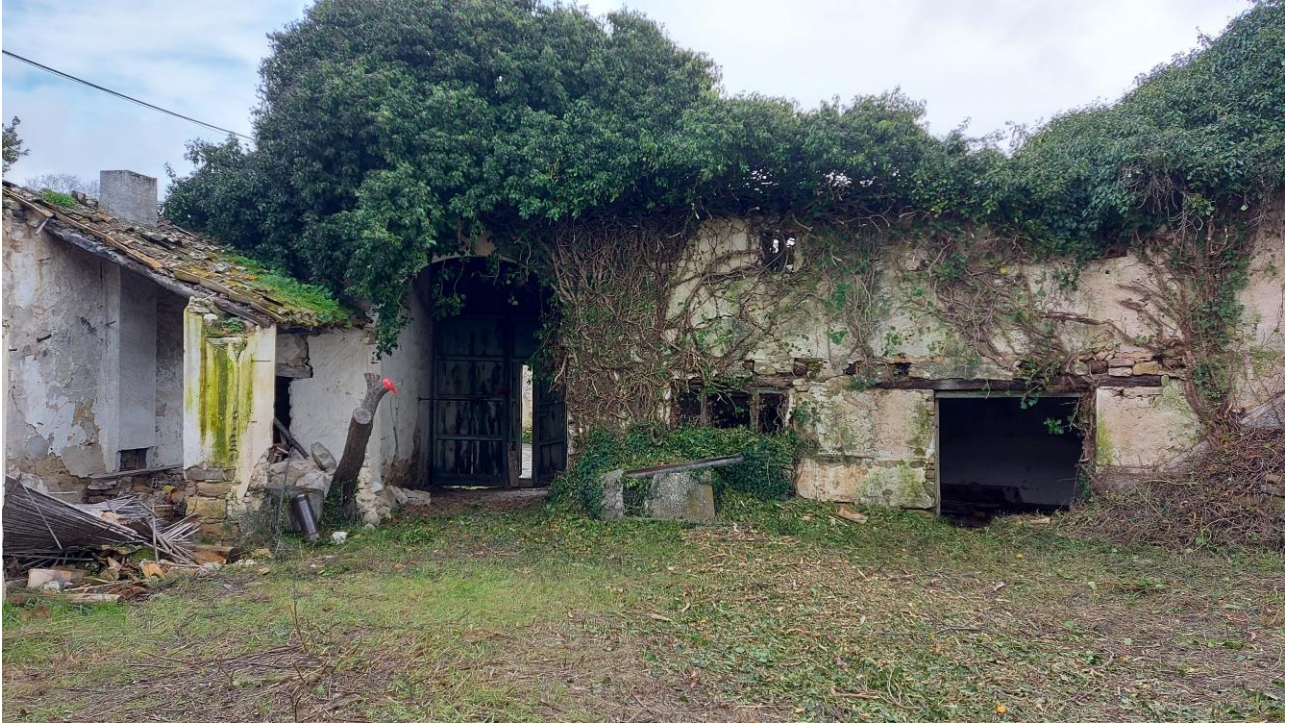
Veduta portale accesso alla corte sulla via Nuoro verso la corte interna
