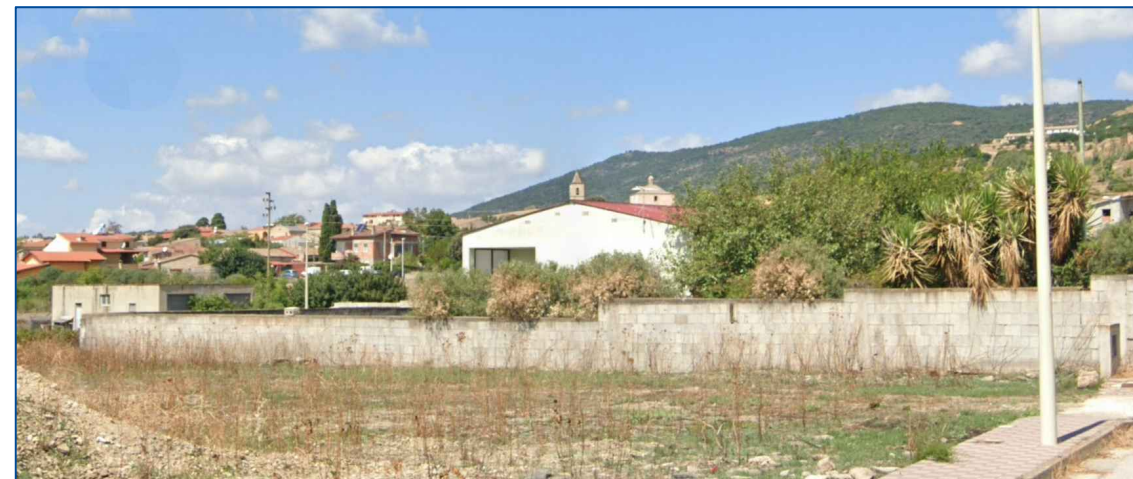
Foto 2 - Recinzione lato Nord verso Lotto PIP N.3
