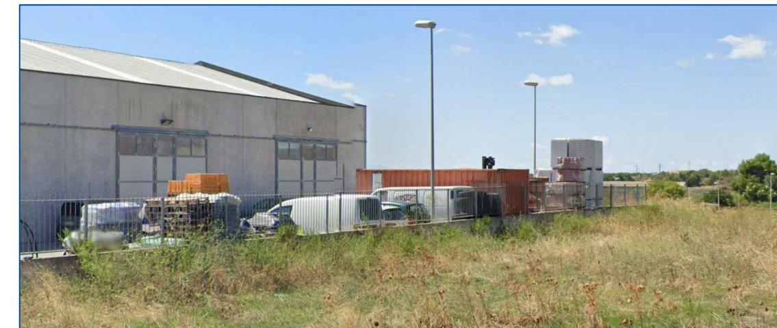
Foto 5 - Recinzione lato Sud verso Lotto PIP N.8
