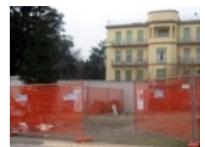
ALLESTIMENTO CANTIERE STRADALE
