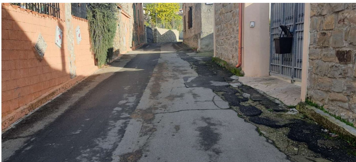
Tratto di strada all'interno del centro abitato
